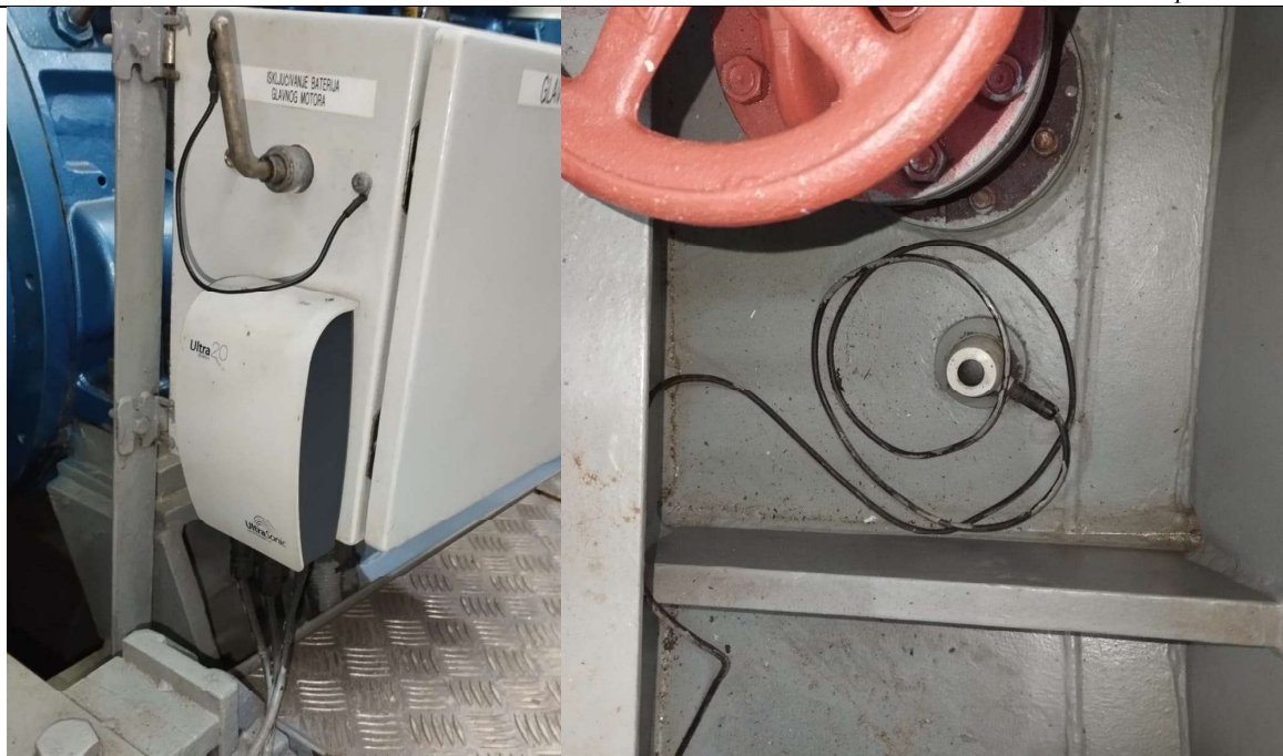
Slika 25. Sastavni dijelovi ultrazvučnog sustava zaštite
