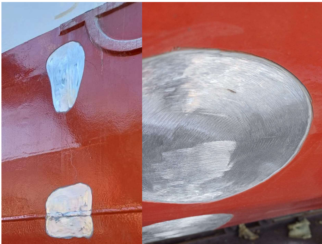
Slika 20. Priprema površine za lokalno obnavljanje silikonskog premaza
