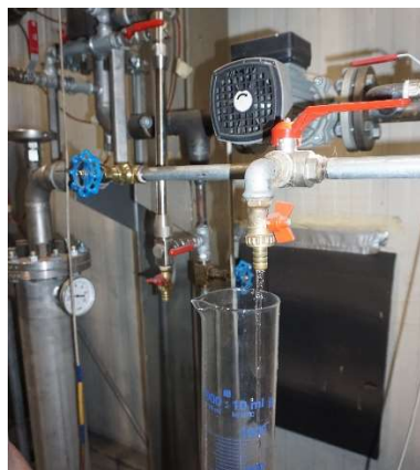
Slika 38. Igličasti ventil i izljevno mjesto s menzurom
