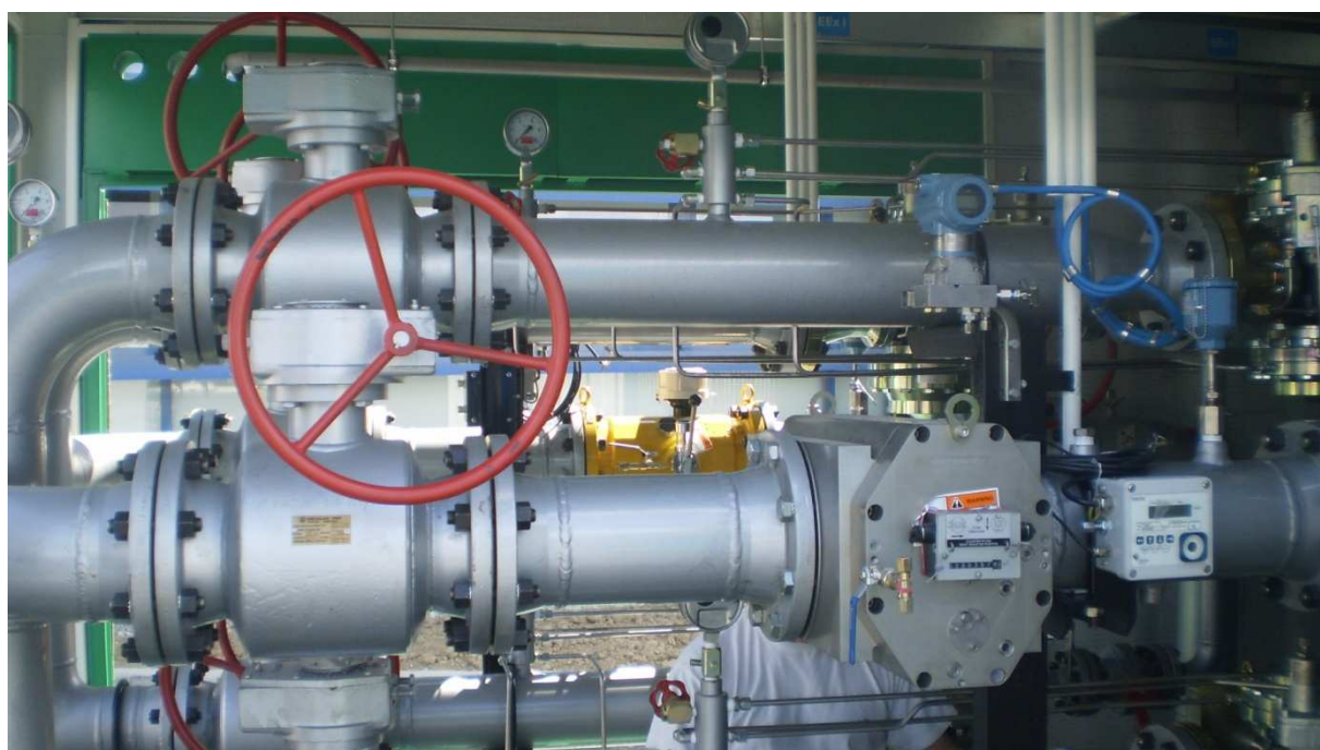
Slika 50. Kuglasta slavina DN 150 i mjerilo protoka plina mjerne linije MRS-a
