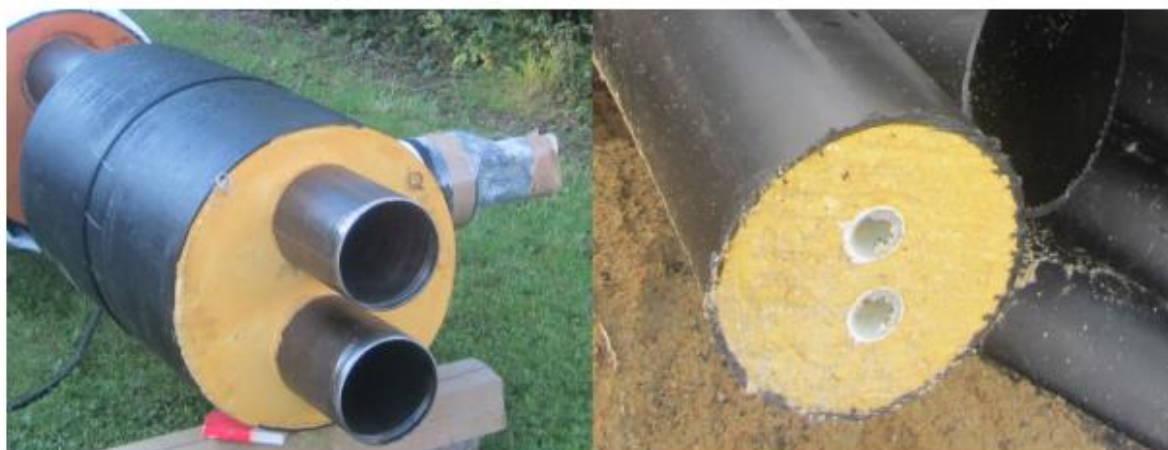
Slika 11 Primjer fleksibilnih i čeličnih cijevi [15]
