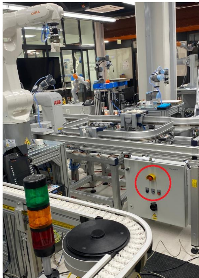
Slika 17. Lokacija upravljačke jedinice.
