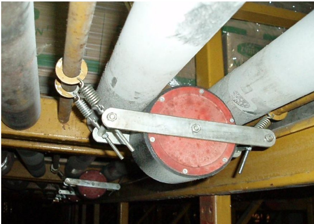
Slika 21. Kočnice na valjčanim trakama
