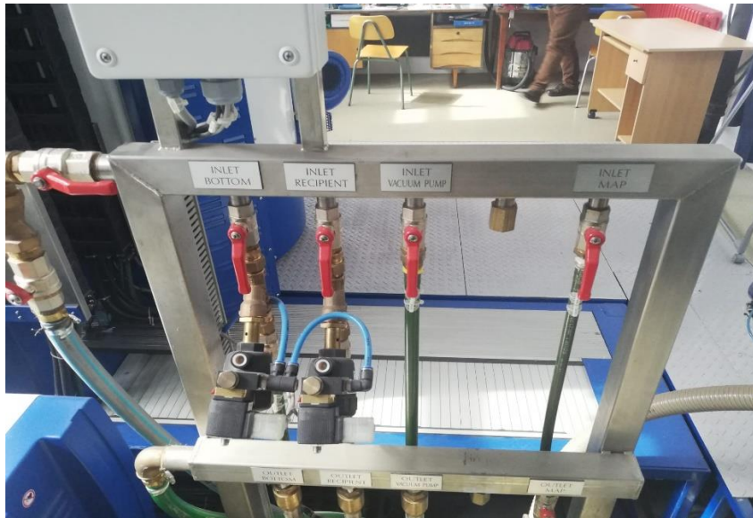
Slika 2.2 Razvod plinova za vakuumsku peć Rübiger PC 70/90
