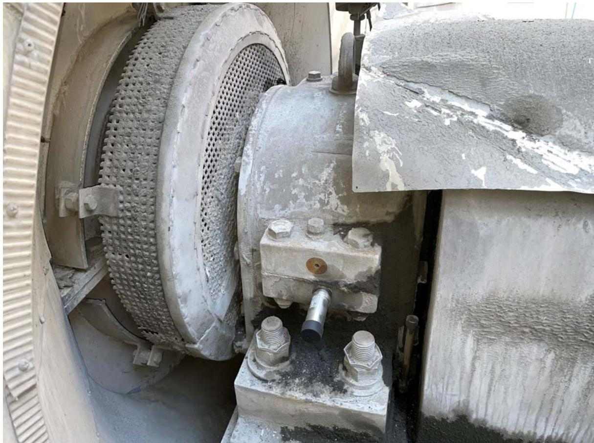
Slika 36. Montirani senzor na ležaju ventilatora [11]
