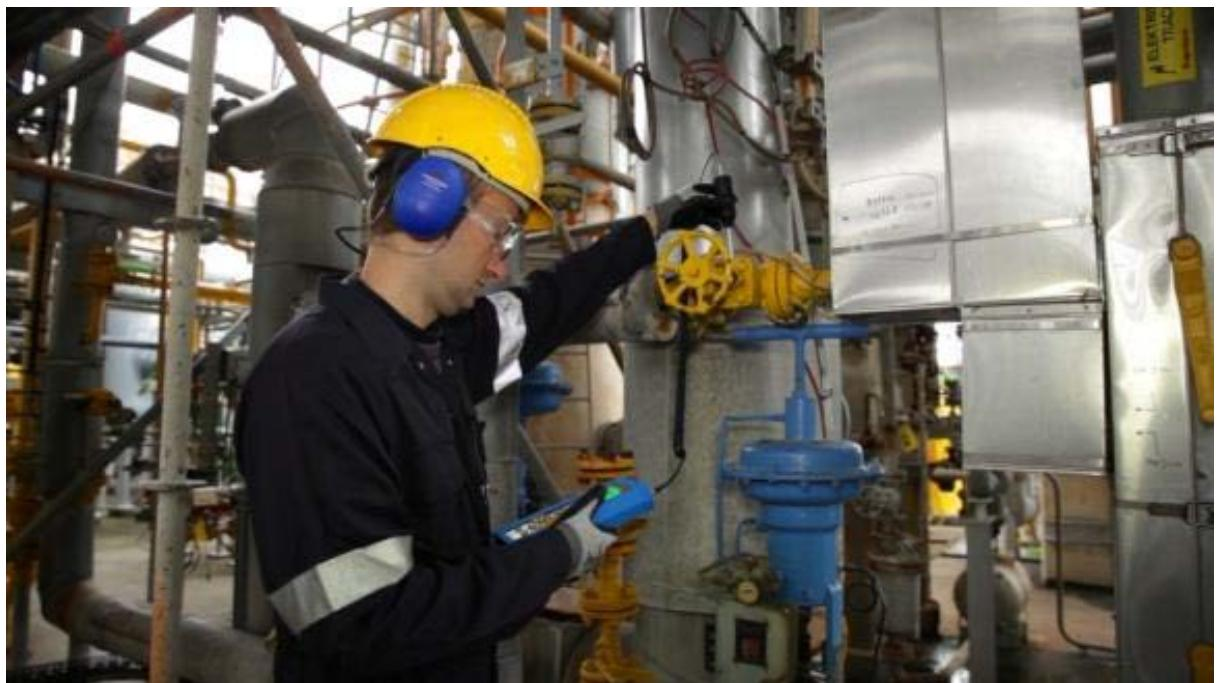
Slika 14. Prikaz ispitivanja ventila ultrazvučnom dijagnostikom [13]
