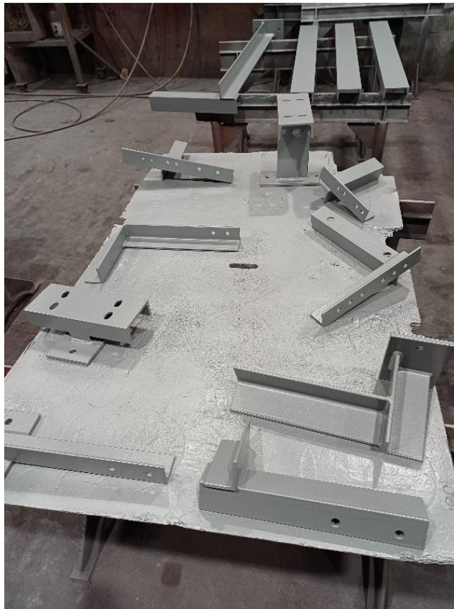
Slika 38. Oslonci premazani temeljnim slojem
