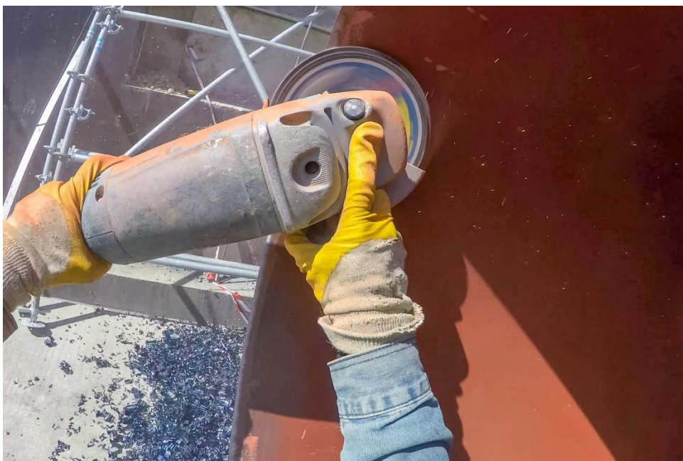
Slika 14. Čišćenje površine rotacijskom četkom [26]
