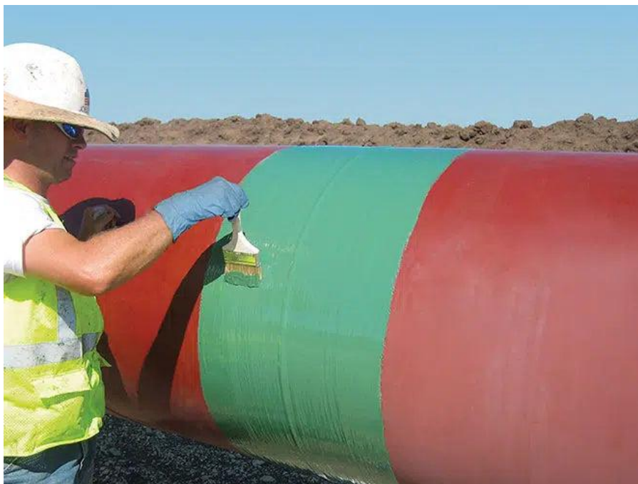
Slika 35. Ručno premazivanje površine [52]
