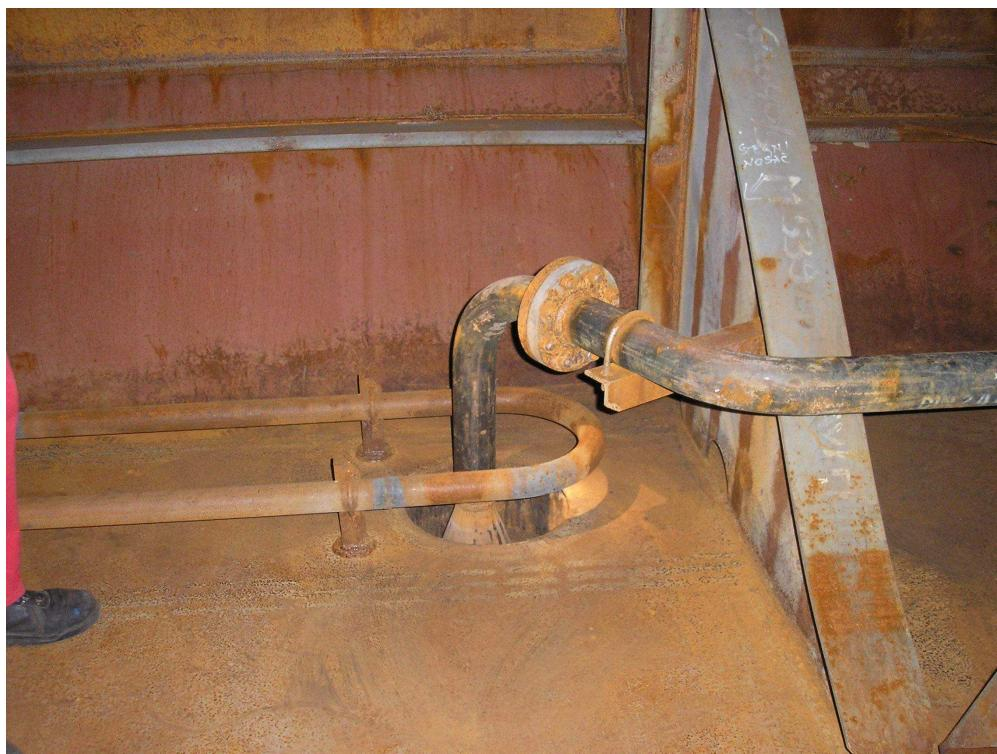
Slika 102 Zdenac i cijev za isušivanje ostatka tekućeg tereta u spremnicima
