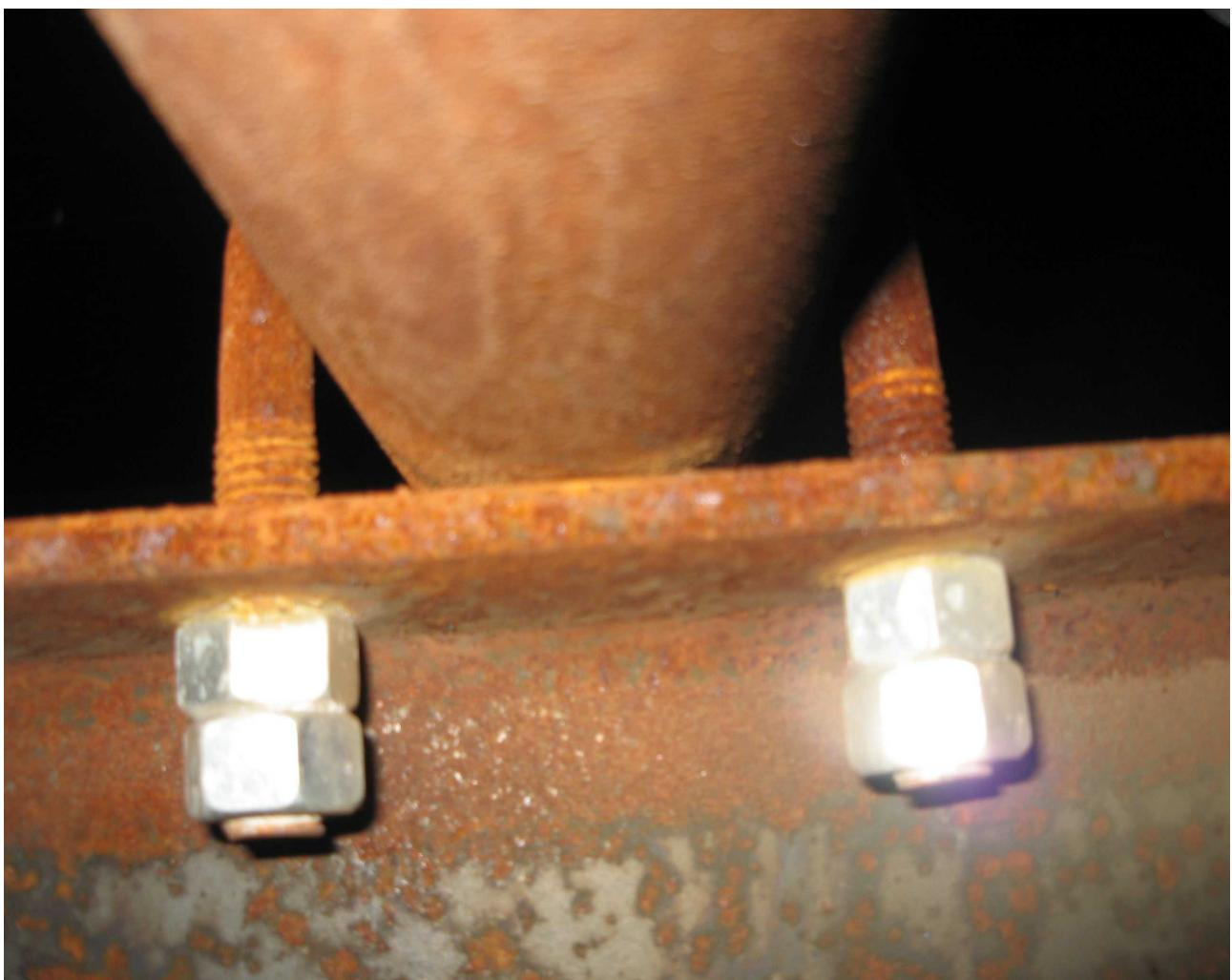
Slika 73 Fotografija jedne klizne obujmice, cijevi i U-profila.
