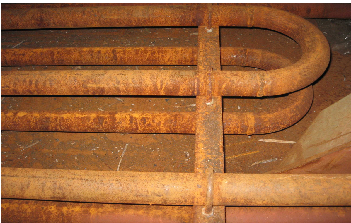
Slika 69 Fotografija serpentina montirane na U- profil
