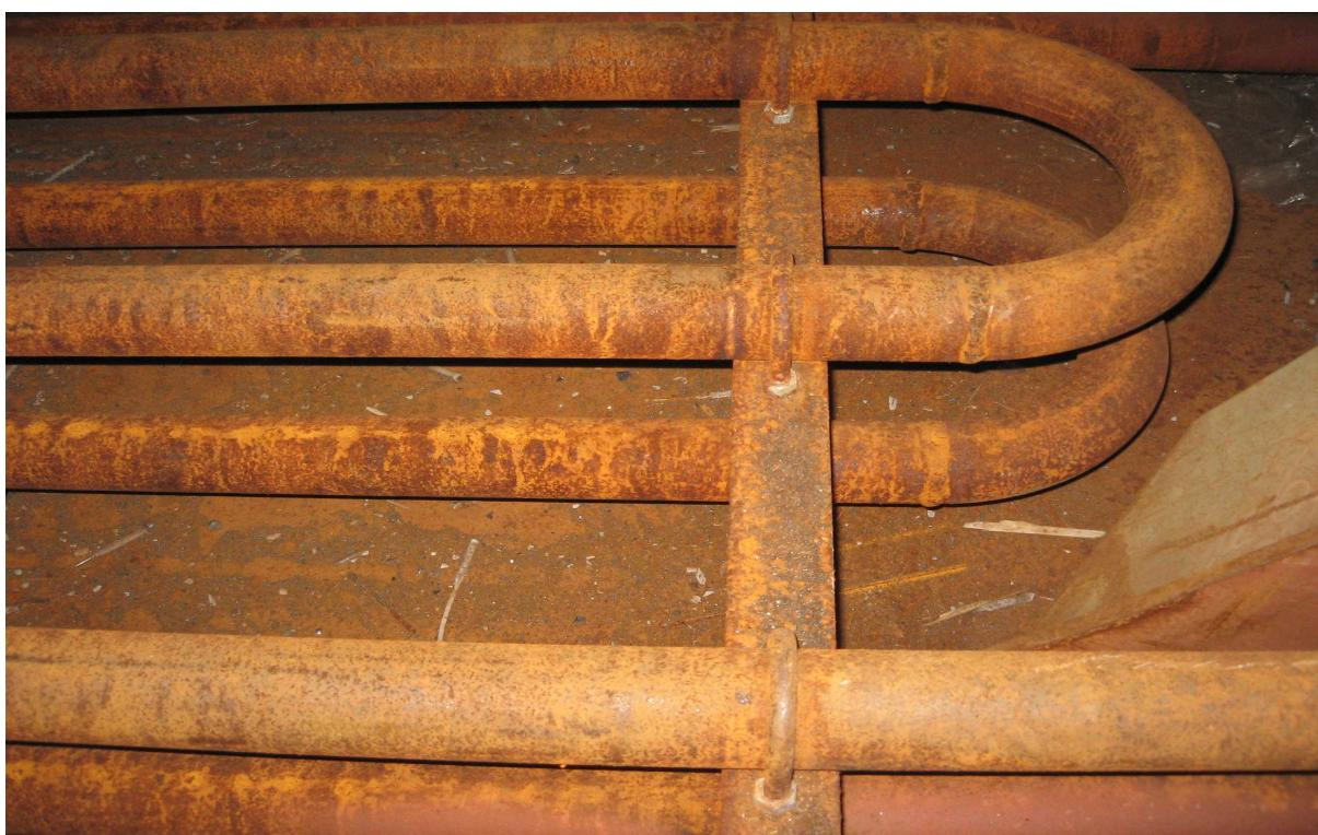
Slika 69 Fotografija serpentina montirane na U- profil
